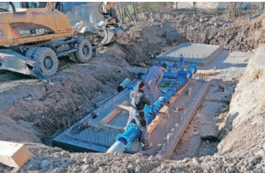
Gradnja novih razdelilnih vodovodnih jaškov ob krožišču FOTO: IGOR KRŽIŠNIK
